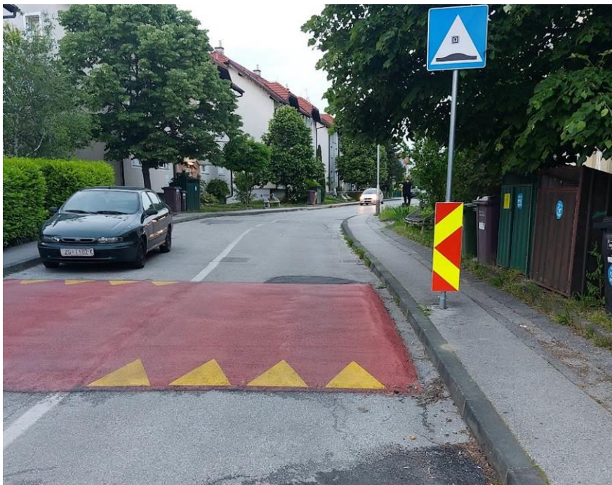
Načelni izgled izvedene uzdignute plohe (Zagreb)
