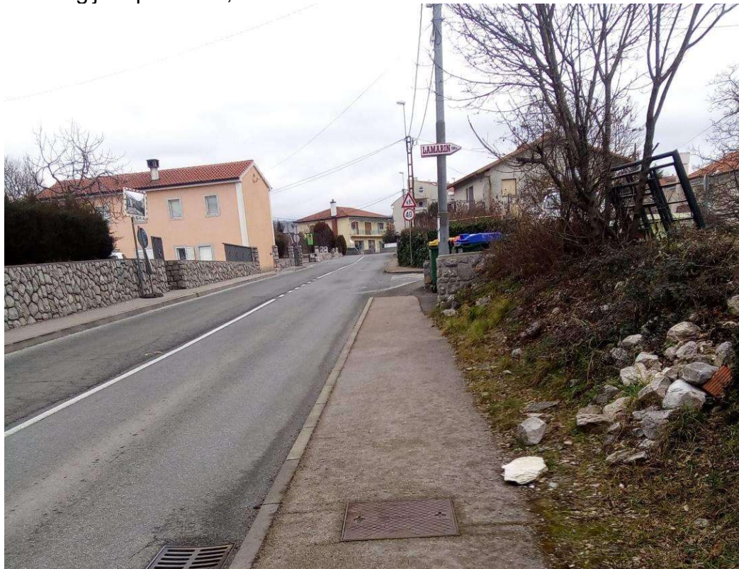
Postojeći stup za postavljanje elektro-ormarića
