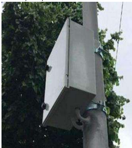
Primjer postavljanja razvodnog ormarića
