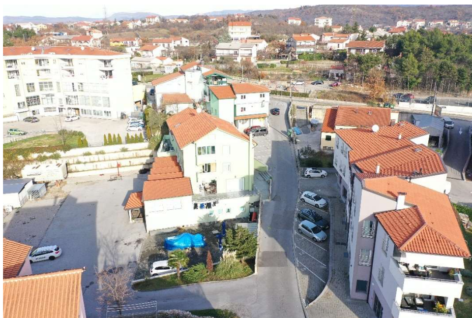
Slika 24. Postojeće stanje – početni dio ulice
