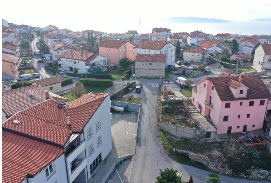
Slika 25. Postojeće stanje – završni dio ulice, spoj prema lokaciji 15
