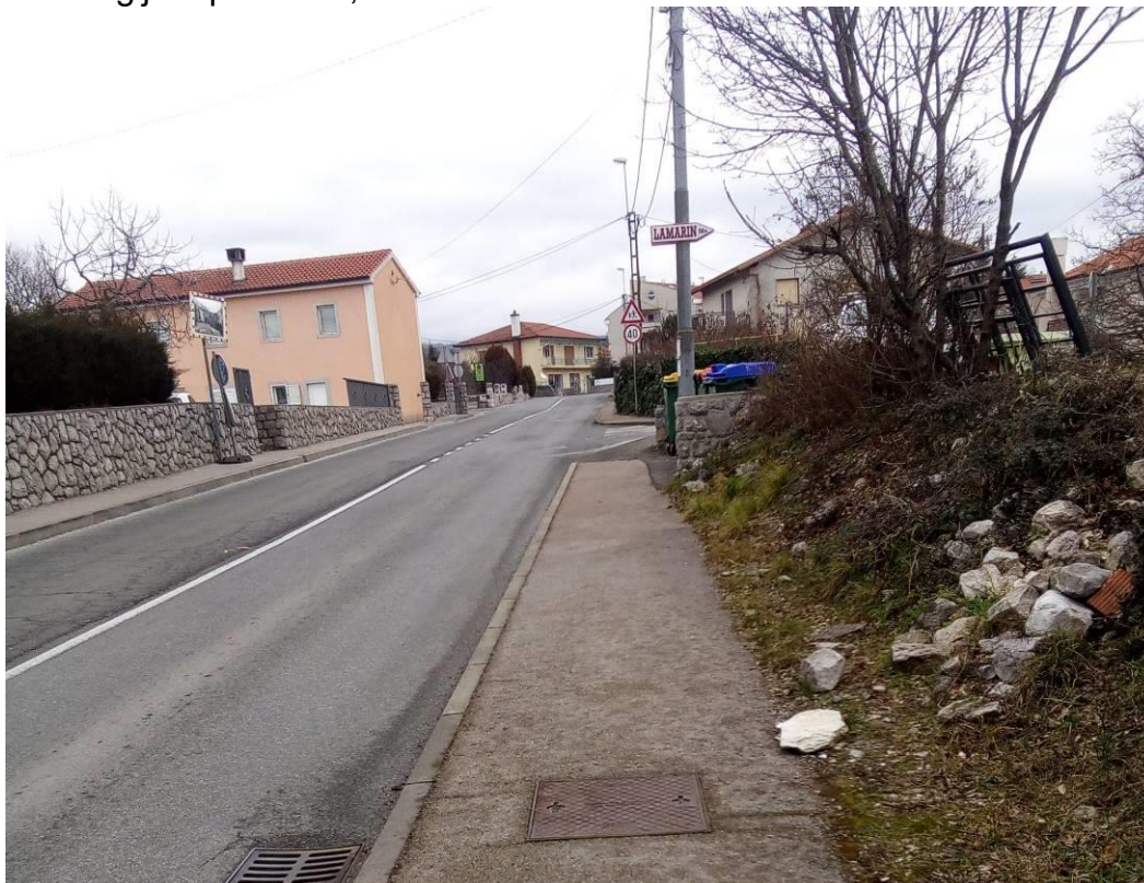
Postojeći stup za postavljanje elektro-ormarića
